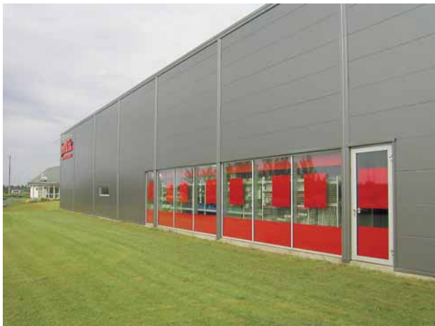
Blænding eller dominerende tilklæbning af vinduer, der er synlige fra offentlige arealer, er som hovedregel ikke tilladt, da bygningerne kommer til at virke lukkede og utilnærmelige. Vælg i stedet som her en løsning, hvor der er kig ind i butikken.
