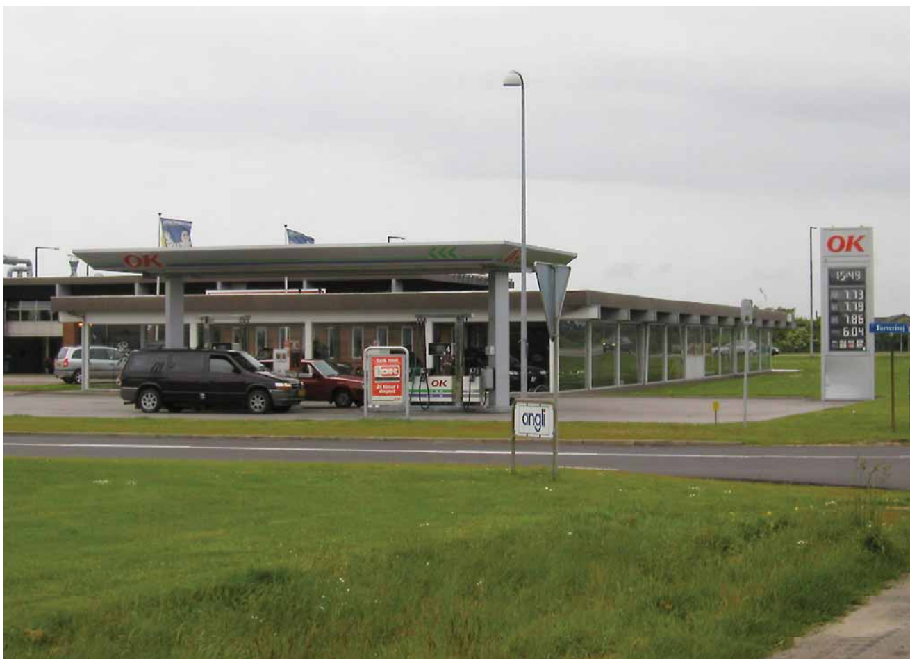
Ved service- og benzinstationer skal der være mulighed for en enkel og markant skiltning med ét logoskilt og ét standardprisskilt. Til gengæld skal den øvrige skiltning begrænses.
