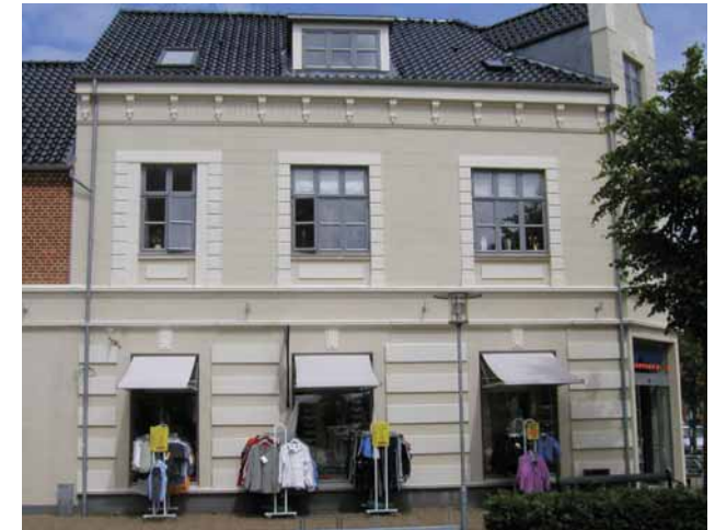
Markiser bør som regel vælges med en bredde, der svarer til vinduerne. Men i visse situationer kan det også gå, at markisen har en bredde, så den f.eks. dækker vinduerne to og to. Mange steder har der været en enkel og smuk tradition for markiser med hvid lærredsdug.
